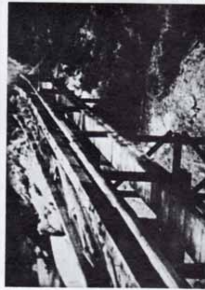
Flottnings- anläggningar i Neuburg.
